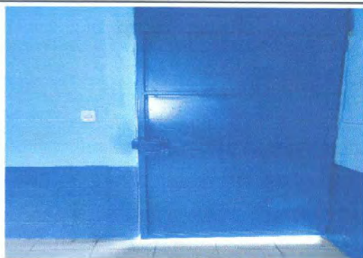
Foto 1: panorama de reparación de puertas
