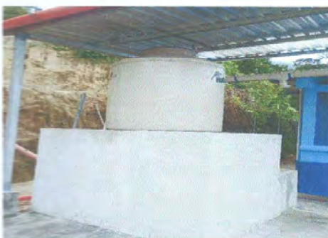
Foto 3: panorama de mejoramiento de agua potable
