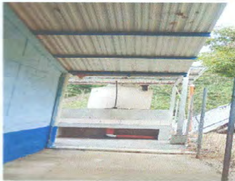
Foto 1: panorama de mejoramiento de agua potable
