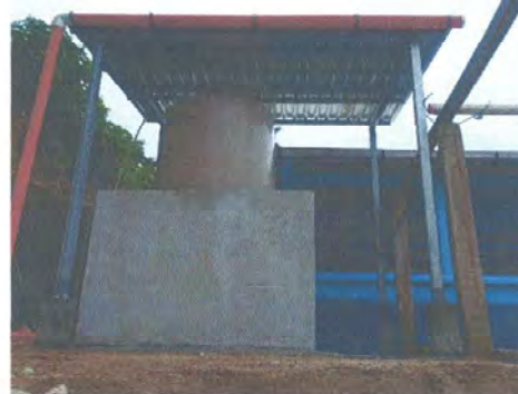
Foto 2: panorama de mejoramiento de agua potable
