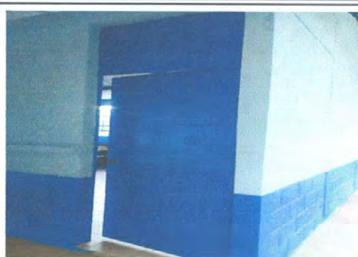
Foto 2: panorama de reparación de puertas
